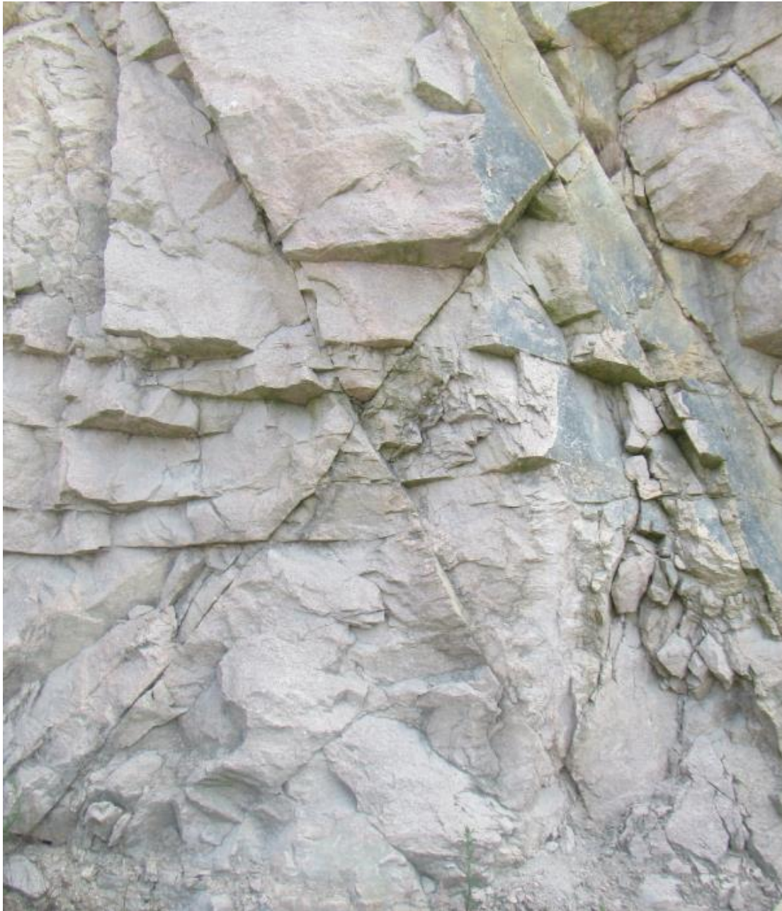
Fig. 7. Eksempel på et X-kryssings sprekkesystem. På bildet er det vist fire retninger av sprekker: to med vinkel på ca. 50 grader, en ca. horisontal og en vertikal.
